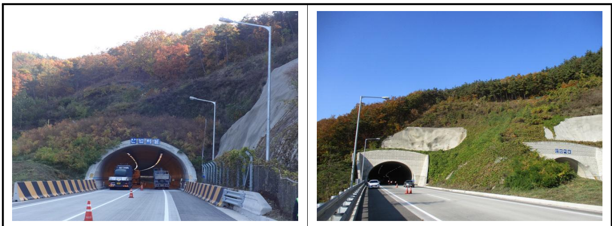
【사진 2.3.21】 사면 전경
