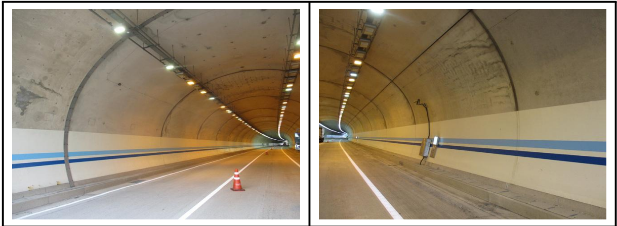
【사진 2.3.3】 라이닝 측벽부 전경
