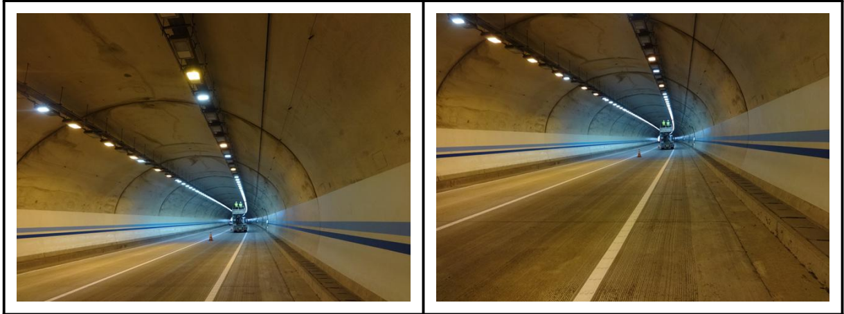
【사진 2.3.15】 라이닝 천단부 전경
