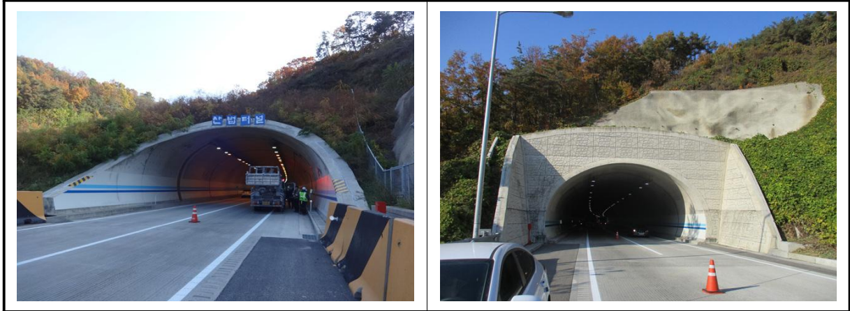
【사진 2.3.19】 갱문 전경
