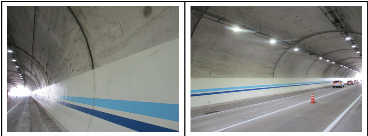
【사진 2.3.17】 라이닝 측벽부 전경
