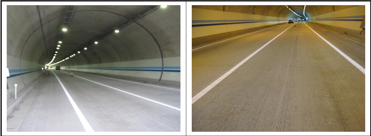
【사진 2.3.11】 포장부 전경
