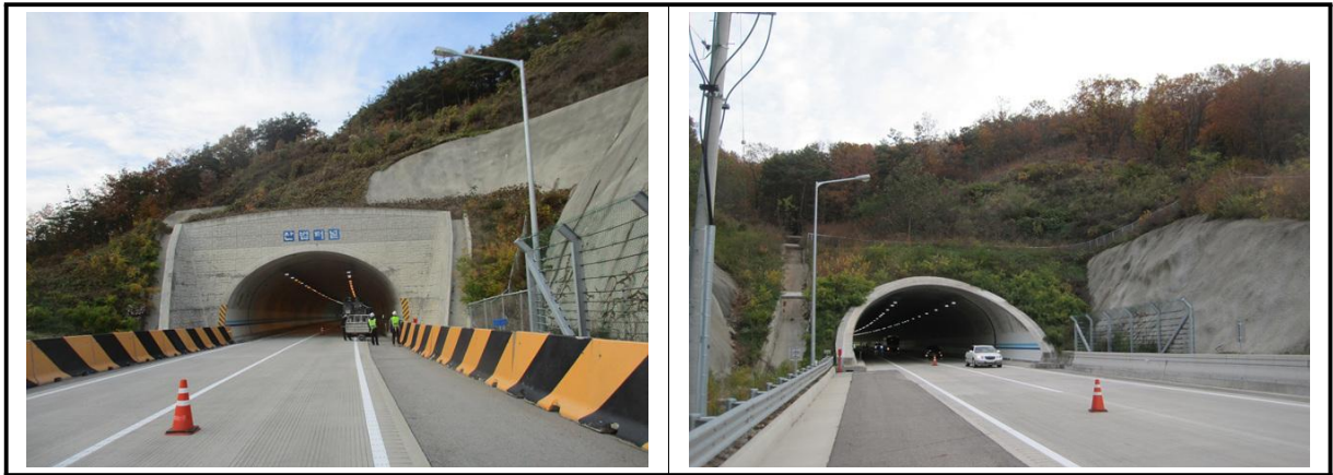
【사진 2.3.5】 갯문 전경
