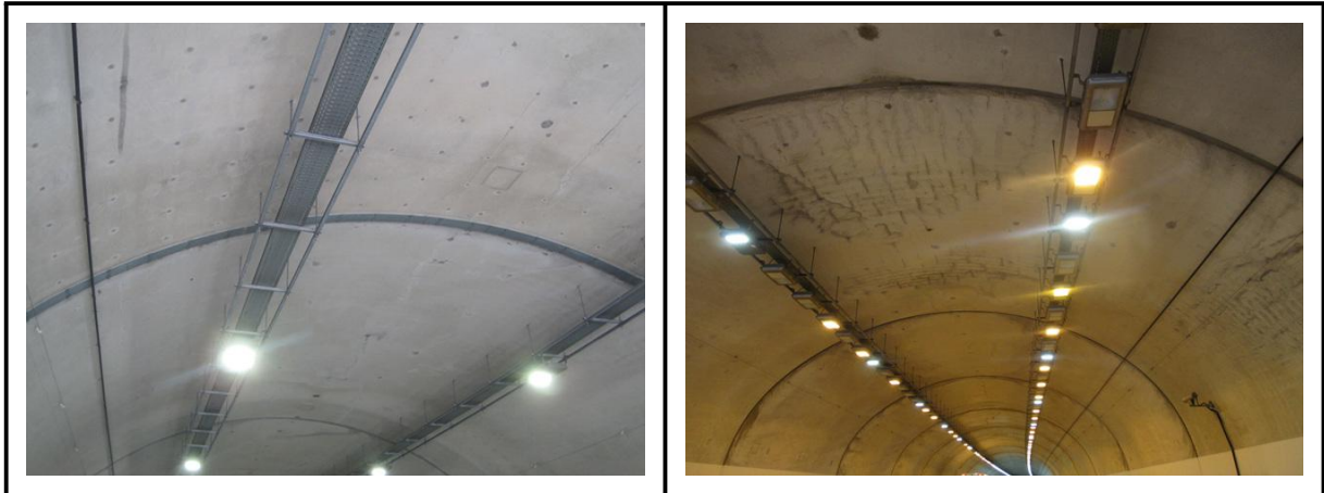
【사진 2.3.1】 라이닝 천단부 전경
