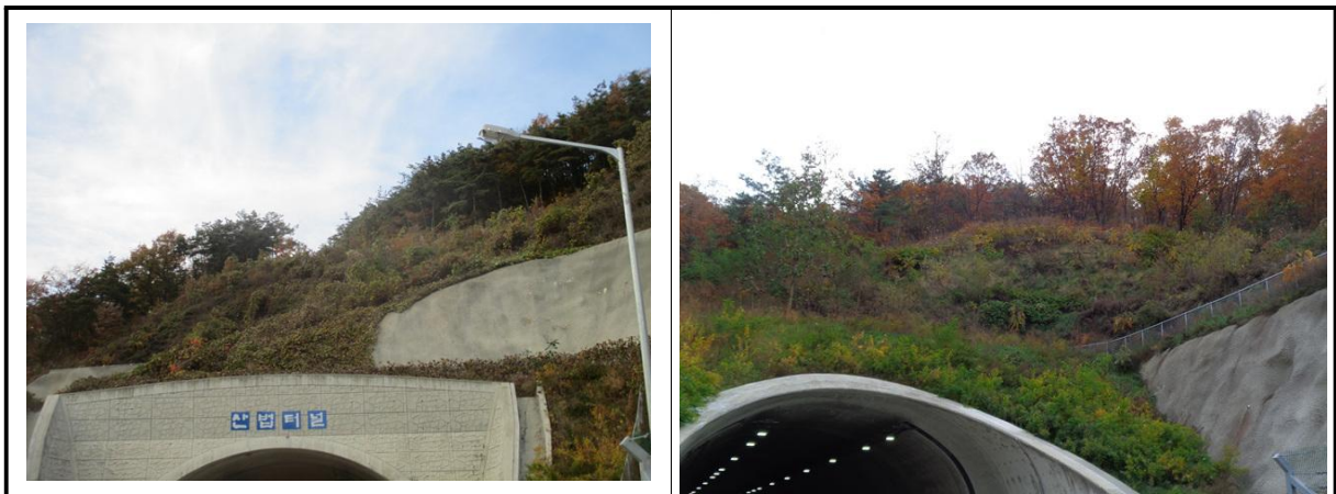
【사진 2.3.7】 사면 전경
